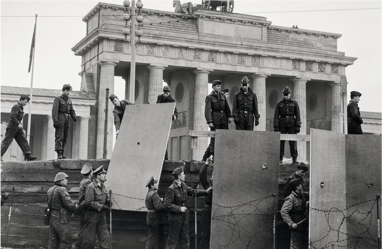
Construction du mur à la porte de Brandebourg. Crédit : DR.
