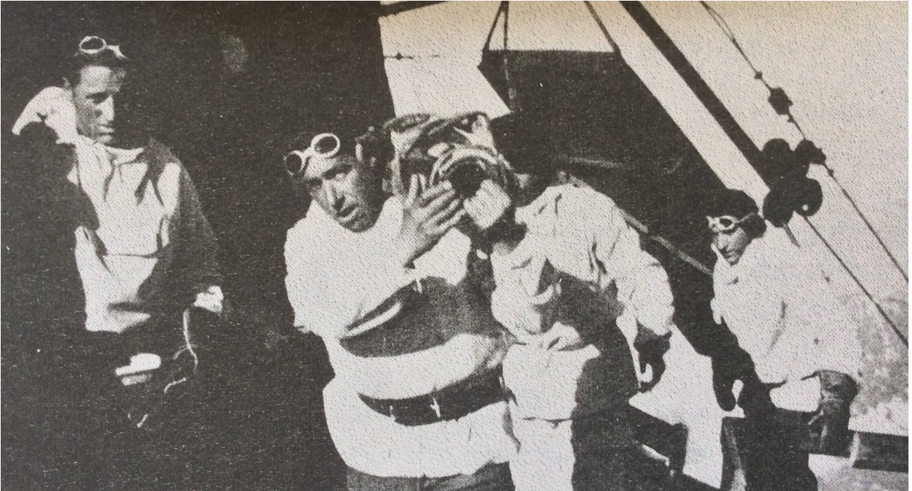
L'ADC FABBRI décharge un tube sur la plateforme.
