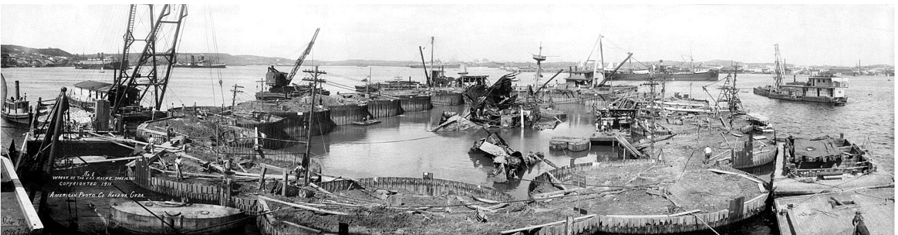
L'épave de l'USS Maine entourée par les batardeaux le 16 juin 1911.
