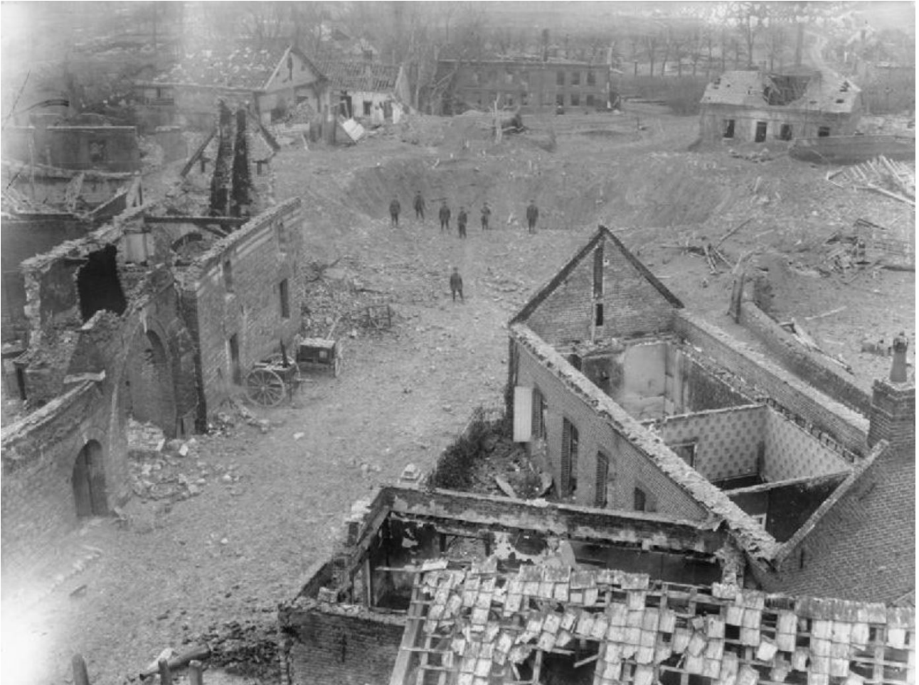
Cratère de mine sur la route traversant Athies, Pas-de-Calais , pour gêner le suivi britannique.
