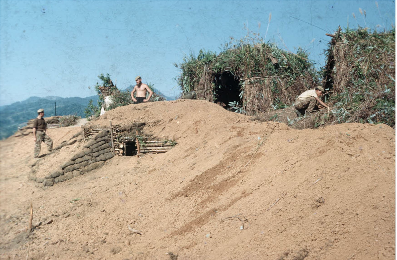
ECPAD : Position d'arme automatique, face ouest.
