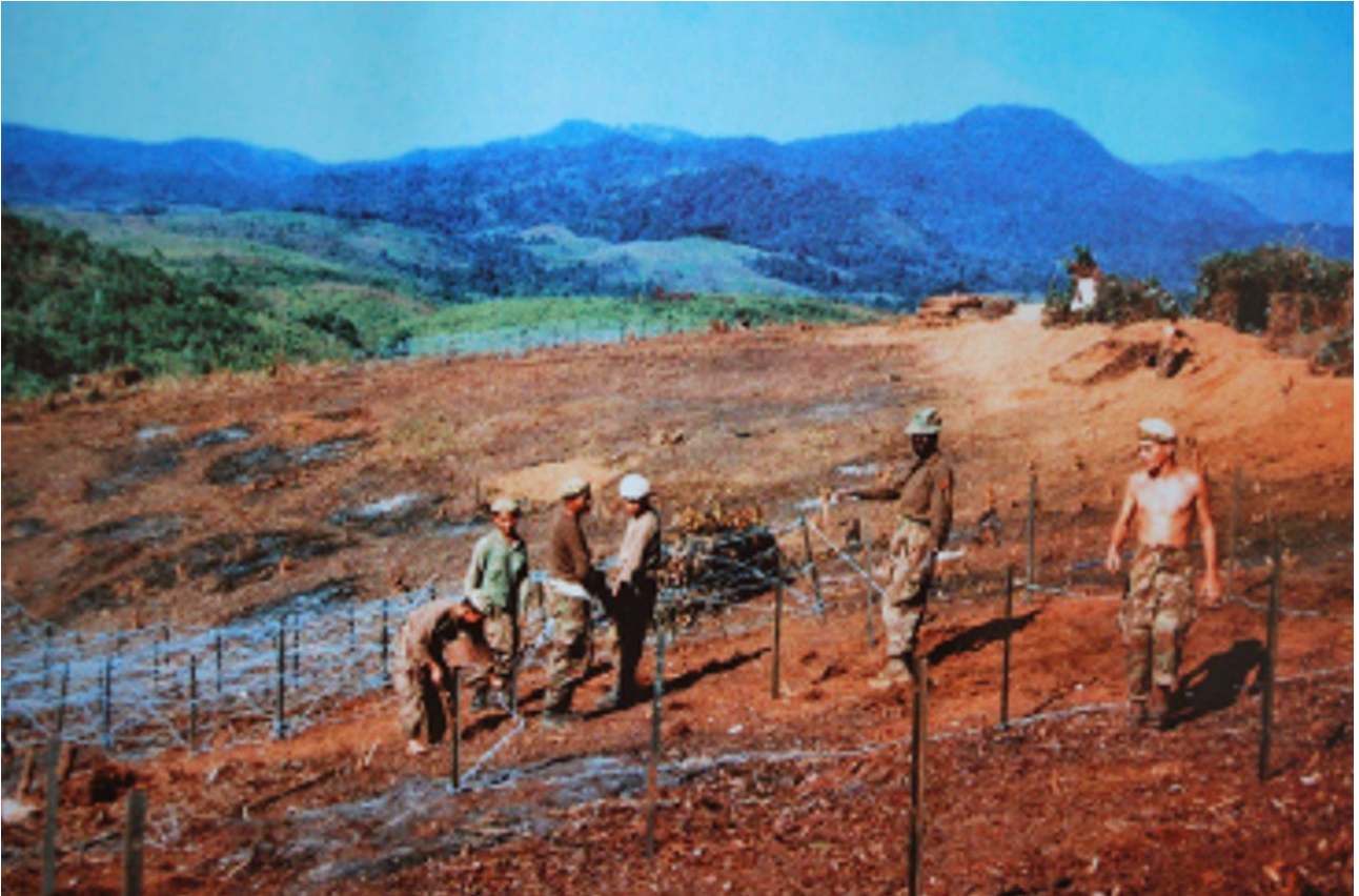
ECPAD : installation de barbelés (fond Mauchamp).
