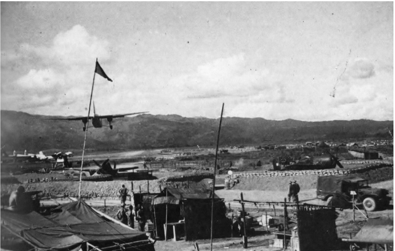
ECPAD : La piste, les alvéoles de Bearcat, la tour de contrôle.
