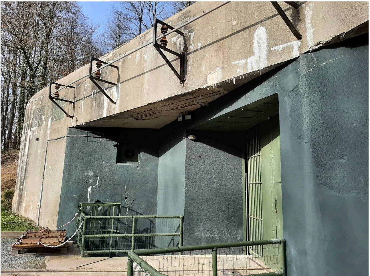
Four à Chaux (entrée des soldats).
