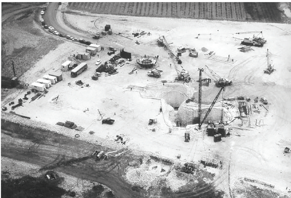
Un chantier de construction d'une zone de lancement pour le futur groupement de missiles stratégiques. Photo DR/CFAS.
